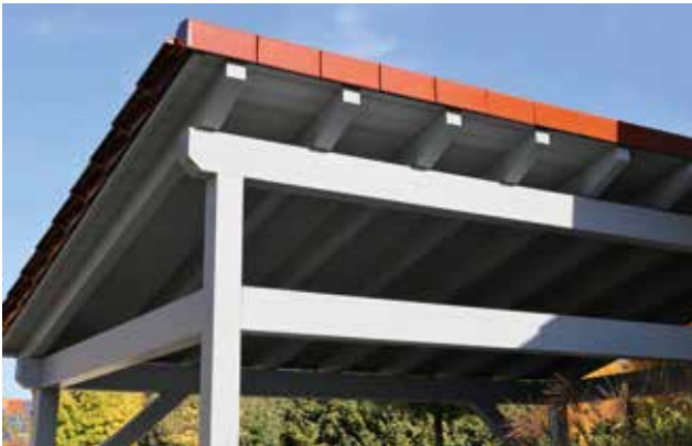
Immer in Bewegung bleiben: das elastische Bindemittel punktet vor allem bei nichtmaßhaltigen Holzbauteilen
