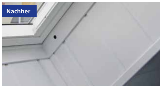
Schwieriger Fall: Dachflächenfenster mit Wasserschaden vor und nach der Beschichtung mit AquaVision® Isolier-Grund
